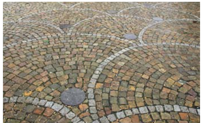
2 BESTRATING IN PAUWSTAARTVERBAND, ZANDSTEEN EN BLAUWE HARDSTEEN, PLACE DE L'ÉGLISE, HOUFFALIZE
