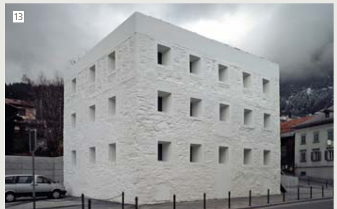
13 Het vroeger wijdverspreide gebruik om natuursteen te schilderen, laat de structuur en de lijnen van een gebouw duidelijk opvallen. THE YELLOW HOUSE (NU WIT GESCHILDERD), MUSEUM IN FLIMS (CH), ONTWERP VALERIO OLGIATI
