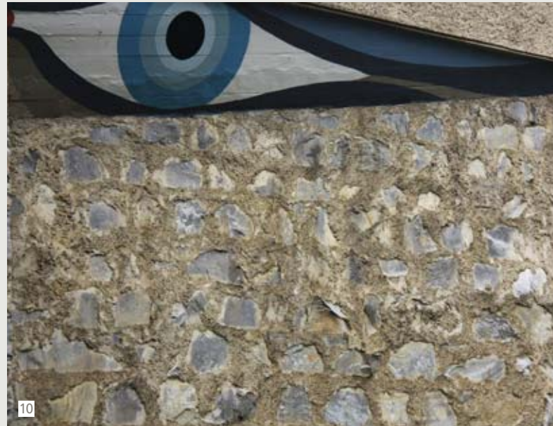
10 Door hetzelfde belang te hechten aan de breukstenen en de mortel waarin ze lijken te verdrinken, laat de architect een nieuw fascinerend materiaal ontstaan. CHEMIEGEBOUW, SART-TILMAN, LUIK, ONTWERP CLAUDE STREBELLE
