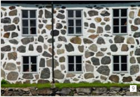
9 Hoewel de stenen heel groot zijn, lijken ze in een wit mortelbad te drijven. TRADITIONEEL GEBOUW, ZWEDEN
