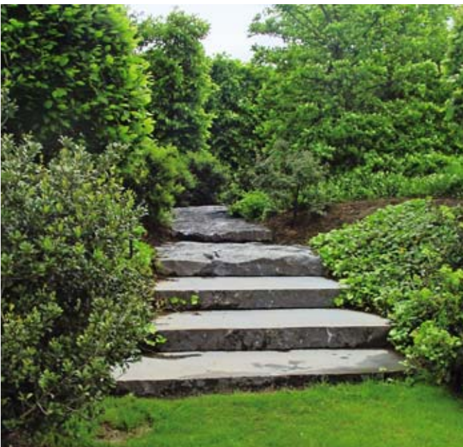
3 Het onderste deel van de trap bestaat uit gezaagde blauwe hardsteen-tegels. Halverwege is dan voor korstplaat van blauwe hardsteen gekozen om de overgang naar een volgend, wilder tuingedeelte extra in de verf te zetten. PRIVÉTUIN, HAUT-ITRE, ONTWERP JEAN DELOGNE
