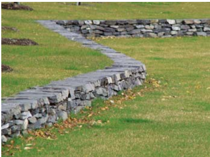
7 Muurtje in plaatselijke schist, geeft een uitgestrekt gazon extra structuur. PROMENADE CHAMPLAIN, QUÉBEC (CA), ONTWERP WILLIAMS ASSELIN ACKAOU/DAOUST LESTAGE
