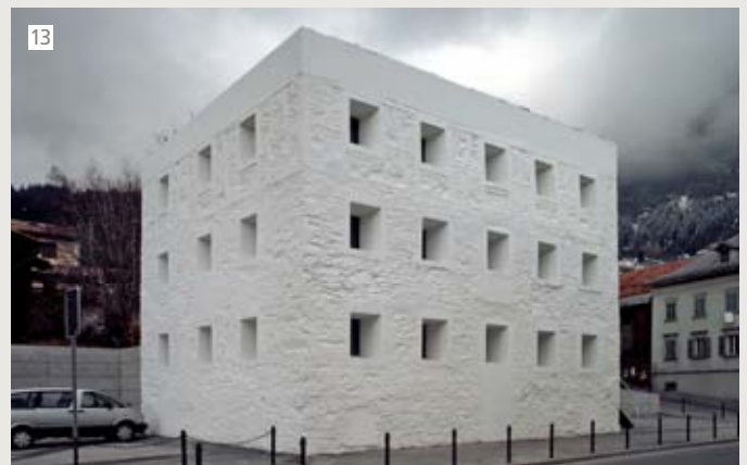
13 La pierre peinte largement employée autrefois fait ressortir la structure et les lignes du bâtiment. THE YELLOW HOUSE (DEVENUE AUJOURD'HUI BLANCHE), MUSÉE À FLIMS (CH), CONCEPTION VALERIO OLGATI
