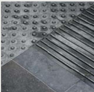
sind. Auch bei den Dehnungsfugen wird diese Verschiebung (Sägezahnmuster) eingehalten. Die dehnungsfugen auf den Bahnsteigen verlaufen quer und wurden alle 7,5 m eingesetzt, sodass sie sich an die Hauptachsen anpassen.
