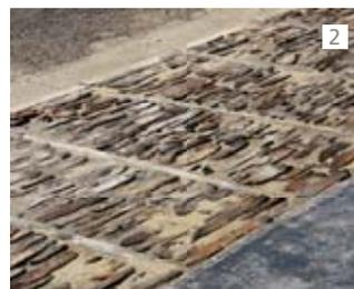
2 Hughes Fernet hat in Noirfontaine an einer Garagenausfahrt einen schmalen Gehweg aus hochkant verlegtem Schiefer angelegt, der insbesondere bei Winterwetter aufgrund seiner Griffigkeit das Herausfahren erleichtert. Dazu verwendete er Werksteine aus demselben Schiefer in einem einfachen Verband.
