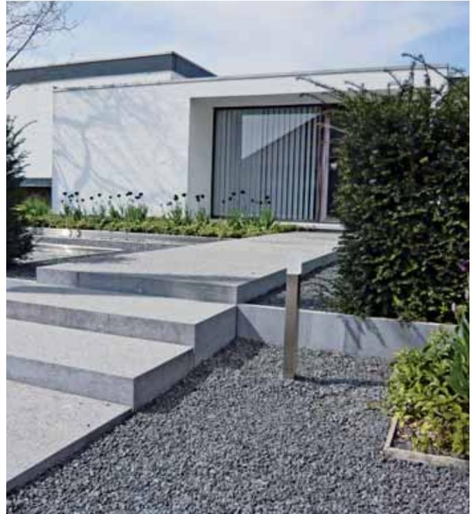
**4** Pour réaliser un escalier de peu de marches, il est possible de préférer une pose verticale des blocs. Les joints doivent alors être réalisés avec un mortier hydrofuge.
