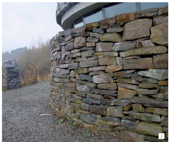
3 Ein organischer Mauerverband für eine Trockensteinmauer, angelehnt an eine Betonstruktur.
