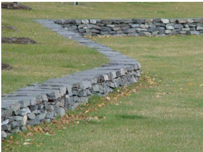
7 kleine Mauer aus lokalem Schiefer, der einer weiten Rasenfläche Struktur verleiht. PROMENADE CHAMPLAIN, QUÉBEC (CA), ENTWURF WILLIAMS ASSELIN ACKAOUI/DAOUST LESTAGE
