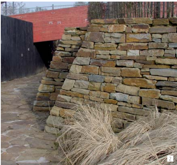
2 Diese hohen Mauern wurden wie Trockenmauern gebaut, nach einer überlieferten Technik aus Wales. Aus Sicherheitsgründen wurde zwischen die Mauer und die Wand stabilisierter Sand gefüllt, um die Stabilität langfristig zu gewährleisten.
