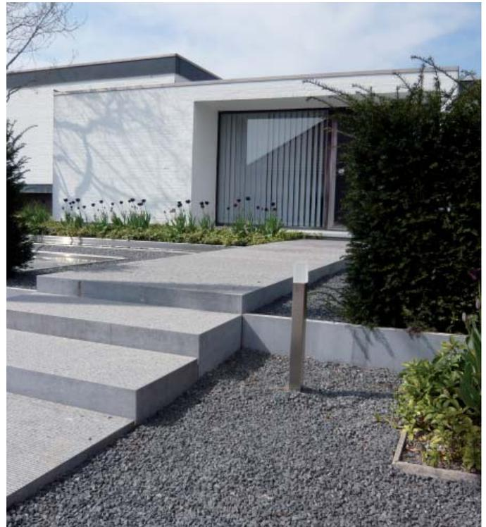
4 Bei einer Treppe mit nur wenigen Stufen ist es möglich, eine vertikale Verlegung der Steinblöcke zu wählen. Für die Fugen muss dann ein wasserabweisender Mörtel genommen werden.
