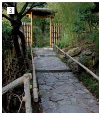
**1** Podeststufen-Effekt für Pflaster aus schiefrigem Sandstein, die so verlegt eine Podeststufen mit niedrigen Stufen bilden, über die ein Fahrzeug fahren kann.
