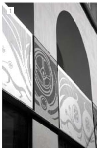
**1** Cette frise périphérique, constituée d'une suite de motifs découpés dans la pierre bleue et dans des tôles d'inox microbillé, fait rupture entre le rez-de-chaussée et le 1<sup>er</sup> étage de cet immeuble restauré. Auparavant, ces deux niveaux étaient constitués de cordons de pierre et/ou de garde-corps en fonte. Des échantillons ont été réalisés pour vérifier la perception des motifs, créés à partir de l'agrandissement d'un détail présent sur les pierres d'origine du second étage.
