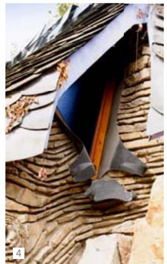
**4** Meurtrière dans une façade organique de moellons d'arkose, avant rejointoyage, et fenêtre triangulaire enchâssée dans du zinc.
