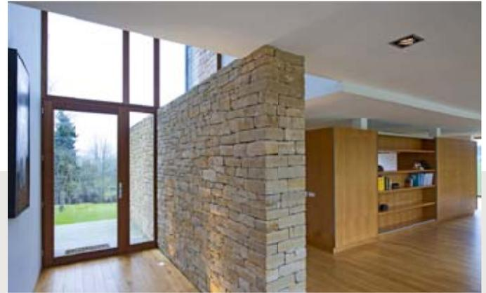
précise tout en gardant un aspect brut. Ils sont posés avec des joints intérieurs de mortier étroits et suffisamment profonds pour être invisibles.
