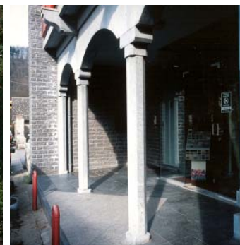
Blau gescurte und alt scharrierte Platten, grau gescurte Säulen
