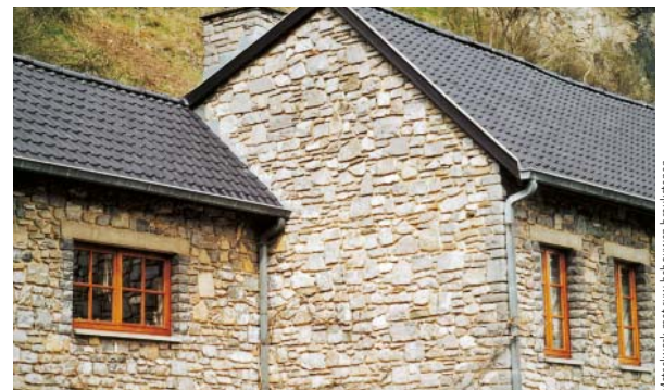
Metselwerk met ruw behouwen breukstenen
