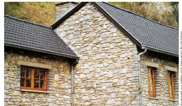
Mauerwerk aus gelben groß behauenen Bruchsteinen
