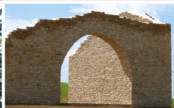
Rockenmauerwerk
