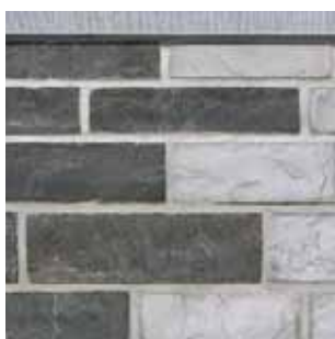
Moellons clivés et sablés
