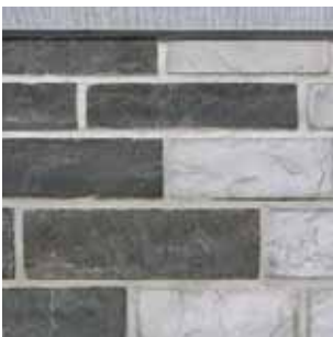
Gespaltene und sandgestrahlte Werksteine
