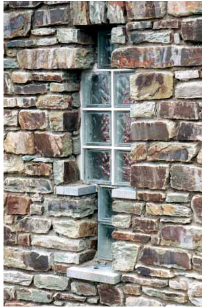
Lichtung einer Garage, Arch. R. Dehliemaison
